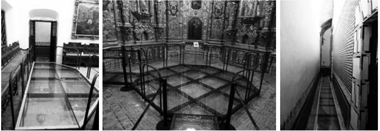
Figuras 5, 6 y 7. Pasarela colocada en pasillos laterales e interior de la Casa de Loreto. Fotografías de Alejandra Cortés Guzmán.
