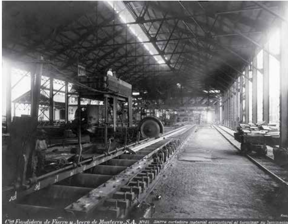
Figura 13. N° 21. Sierra cortadora de material estructural al terminar su laminación, ca. 1909. Guillermo Kahlo, Monterrey, N.L., México. D.R. © Fototeca Nuevo León-Conarte, Fondo: Fundidora.
