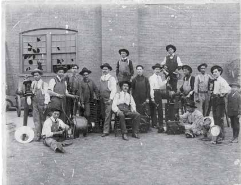
Figura 5. Trabajadores en las instalaciones del Taller Eléctrico, ca. 1925. Refugio Z. García, Monterrey, N.L., México, AHF © 52494 Fototeca Nuevo León-Conarte, Fondo: Fundidora.
