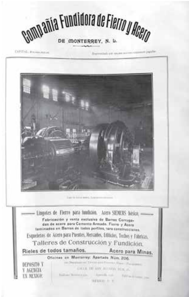
Figura 4. Casa de Fuerza Motriz, generadores eléctricos. Foto cortesía de Marta E. Alfaro.
