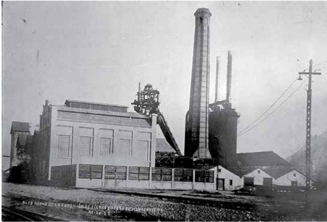
Figura 6. Alto Horno de la Compañía Fundidora de Fierro y Acero de Monterrey, 28 de noviembre de 1922. Junto a él aparece el edificio de la Nueva Planta Eléctrica. Véase Informe Anual 1928. AHF.
