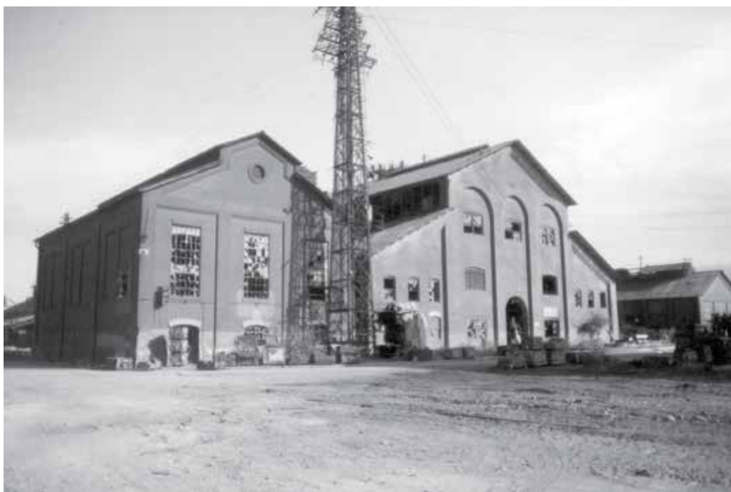
Figura 24. Después del cierre de Fundidora Monterrey, así quedaron los edificios: Planta Convertidora de Energía Eléctrica y el Taller de Fundición. Fotografía: anónimo. Archivo Histórico Fundidora. AHF, s.f.
