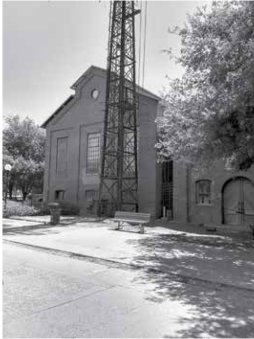
Figura 26. Fachada oeste restaurada en 2001. Fotografía: Alberto Casillas, 2018.
