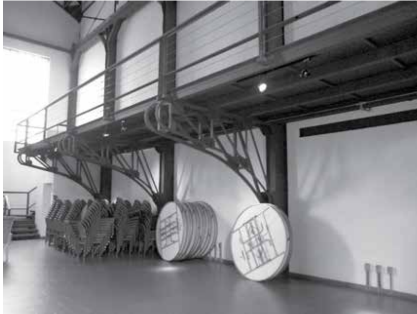
Figura 40. Mezanine estructural lado oriente, 2018. Fotografía: Alberto Casillas.
