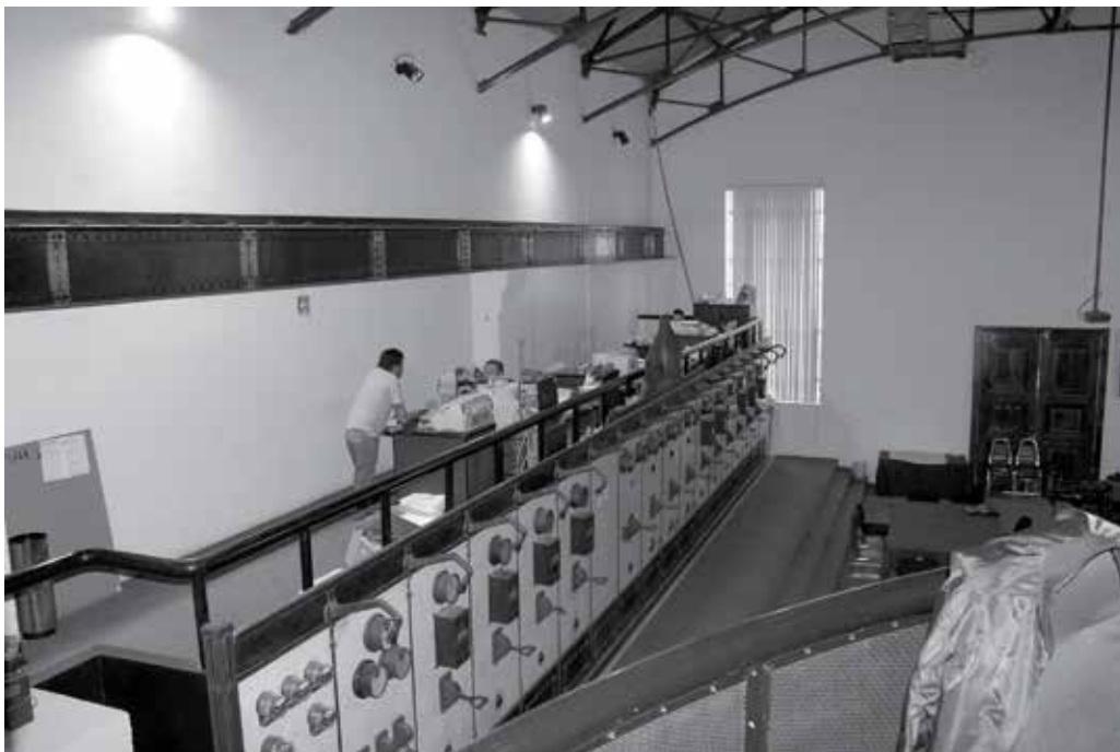
Figura 28. Mezanine construido en la parte superior de los tableros de distribución de energía. Fotografía: Alberto Casillas, 2018.
