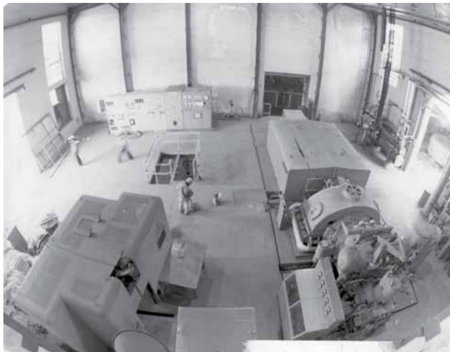
Figura 41. Maquinaria de la Planta Turbosopladora No. 4 de Fundidora Monterrey, 1977. Lauro Leal Salinas, Monterrey, N.L., México. D.R.© 40652 Fototeca Nuevo León Conarte, Fondo: Fundidora.
