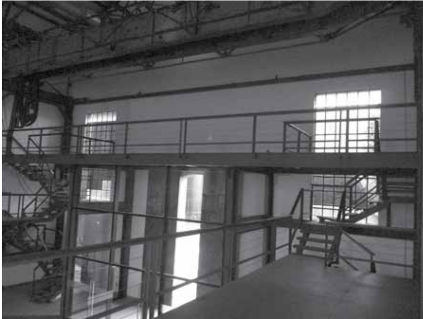
Figura 39. Exclusa y mezanine en fachada sur, 2018. Fotografía: Alberto Casillas.
