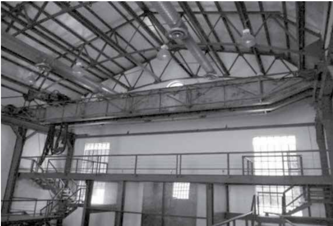
Figura 37. Restauración en 2007 del interior del inmueble, respetando la pintura de la grúa. Fotografía: Alberto Casillas, 2018.
