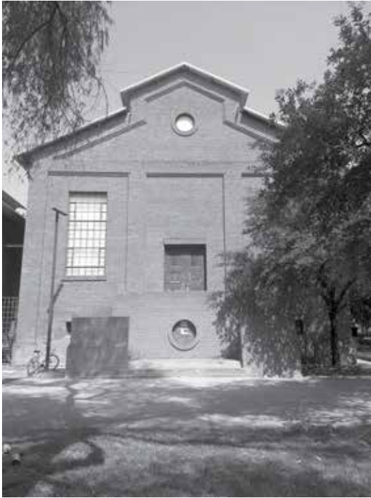
Figura 31. Escalera de concreto añadida en el año 2001. Fotografía: Alberto Casillas, 2018.
