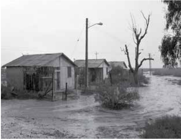
Figura 9. Casas de reparadores de vía.
