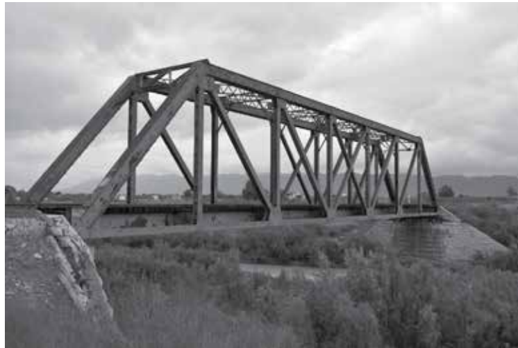
Figura 6. Puente ferroviario San Antonio de Arista.
