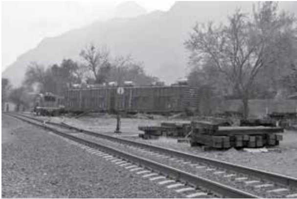
Figura 12. Campamento de reparadores de vía.
