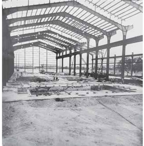
Figura 10. Cimentaciones de formadora de tubo, sótano eléctrico, foso de ondas, mesa de transferencia, 105 metros. AHF, Empresas Filiales, Sección TUNA, Caja 10, Exp. 216.
