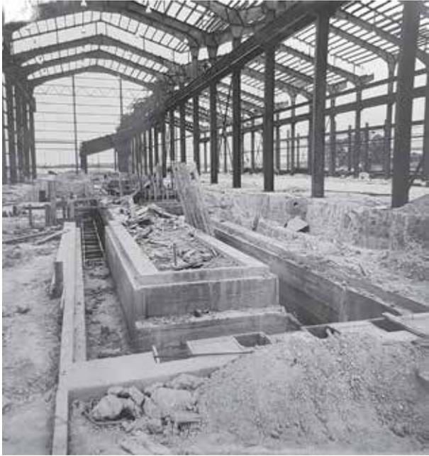
Figura 8. Cimentaciones de decapado y galvanización. AHF, Empresas Filiales, Sección TUNA, Caja 10, Exp. 216.
