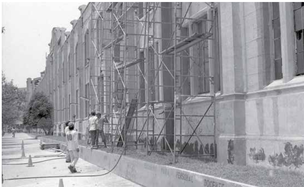
Figura 25. Trabajos de remozamiento de la fachada, 1991. CDAH-UANL.
