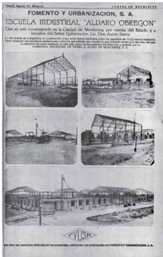
Figura 5. Etapas de construcción, 1928. Jueves de Excelsior .
