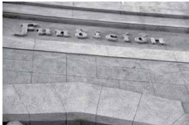
Figura 15. Detalle de los nombres de los seis talleres distribuidos de dos en dos en ambos laterales del edificio. En la imagen, el correspondiente a Fundación, 2014. CDAH-UANL.
