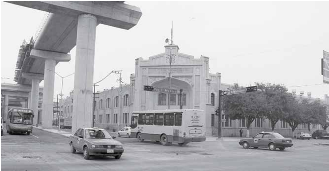
Figura 29. La inacabable Línea 3 del Metro de Monterrey cruza frente al edificio de la Escuela Industrial "Álvaro Obregón" afectando su visibilidad, 2015. Internet.
