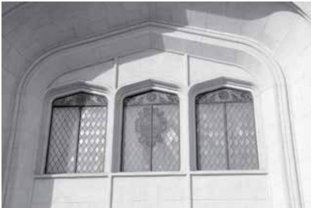
Figura 13. Detalle de los ventanales en la fachada frontal, donde se aprecia el uso del arco Tudor, 2014. CDAH-UANL.
