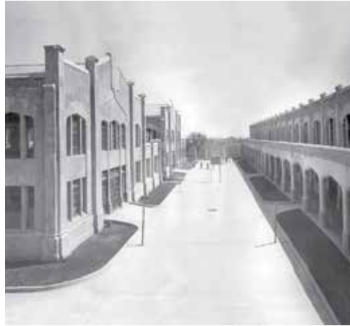
Figura 21. Vista del patio del edificio donde se aprecian las dos naves industriales de Automotriz y Fundición (izquierda) en un volumen separado, ca. 1933. Susana Acosta Badillo y Erika Flor Escalona Ontiveros, Crisol de técnicos... , op. cit.
