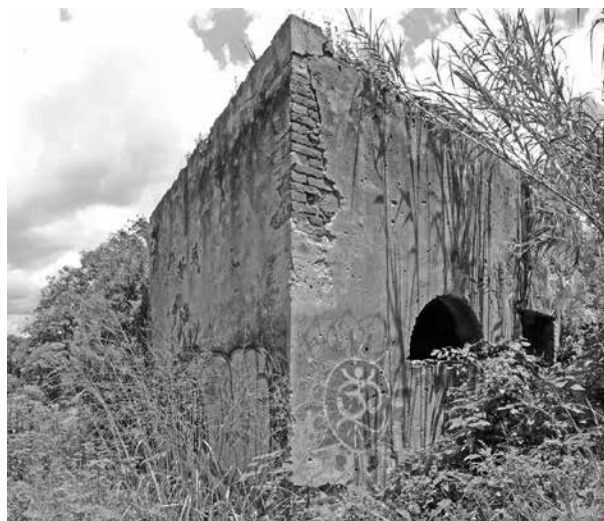
Fig. 18. Caseta para las compuertas de derivación temporal del cauce del río Atoyac. Fotografía de Luis Antonio Ibáñez González (2013).
