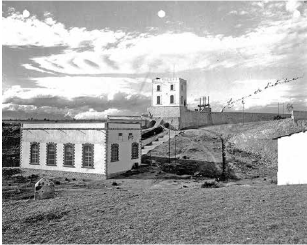
Figura 11. Vista general de la Carmela en 1917, en la que se aprecia sólo una tubería de presión instalada. AHA, AS, c. 4211, exp. 56704, f. 130.
