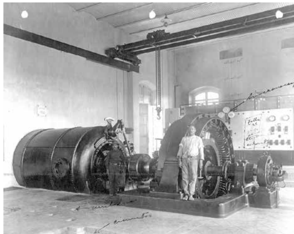
Figura 10. Interior de la planta Carmela en 1917 con el primer grupo eléctrico instalado: la turbina "Carmen" a la izquierda, el generador a la derecha, los tableros al fondo y la grúa viajera en la parte superior. AHA, AS, c. 4211, exp. 56704.
