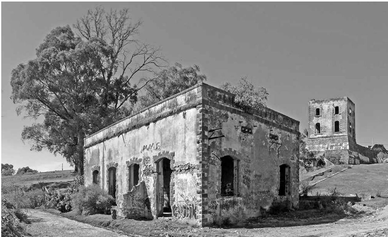
Figura 21. Vista de la casa de máquinas y la obra de toma de la planta hidroeléctrica Carmela. Fotografía de Luis Antonio Ibáñez González (2012).
