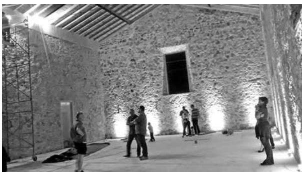
Figura 11. Obras de restauración, primera etapa: adecuación para salón de danza e integración de enduelado y electricidad, con la presencia de la maestra Martha Sahagún Morales, quien fue la impulsora del proyecto de restauración de la ex hacienda por más de 10 años (2014). Expediente Técnico, Sección de Monumentos Históricos, Centro INAH Veracruz, 1993.
