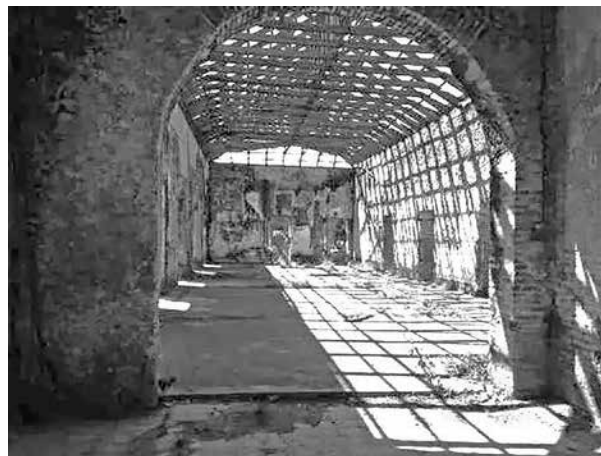
Figura 25. Imagen actual interior de la bodega superior. Expediente Técnico, Sección de Monumentos Históricos, Centro INAH Veracruz.
