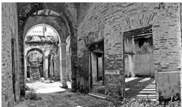
Figura 23. Vista del zaguán de la entrada principal que da al patio central de la fábrica, mayo 2017. Expediente Técnico, Sección de Monumentos Históricos, Centro INAH Veracruz.
