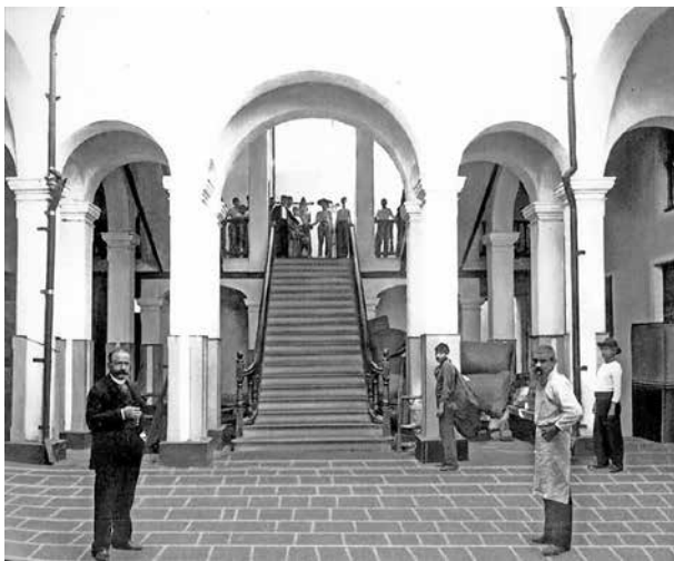
Figura 16. Interior del edificio de la Prueba, en el patio central, con los trabajadores a la izquierda, y en primer plano don Eduardo Casanueva Balsa. Foto del libro Historia de la fábrica de puros La Prueba , de Martha García de Banaglio, Instituto Veracruzano de Cultura, 2016.
