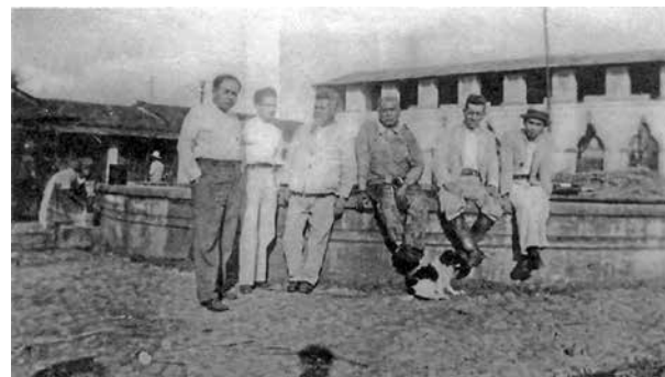
Figura 4. Mismo ángulo del patio principal y de la fuente con algunos de los trabajadores y los patronos en 1940. Archivo del Patronato Pro-Reconstrucción Hacienda de Toxpan.
