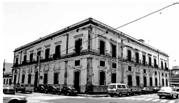
Figura 21. Imagen de las fachadas de las calles Miguel Hidalgo y Miguel Lerdo, tomada en 2006, antes de iniciar la obra de restauración. Expediente Técnico, Sección de Monumentos Históricos, Centro INAH Veracruz.
