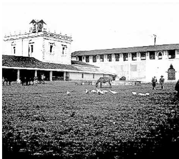
Figura 2. La hacienda de Toxpan en 1908: patio principal y fuente. Archivo del Patronato Pro-Reconstrucción Hacienda de Toxpan.
