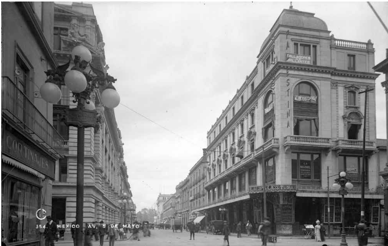
Figura 6. Edificio "La Palestina", Avenida 5 de Mayo, esquina Bolívar. Fototeca Nacional-INAH, Colección Casasola, MID: 77_20140827-134500:122566.
