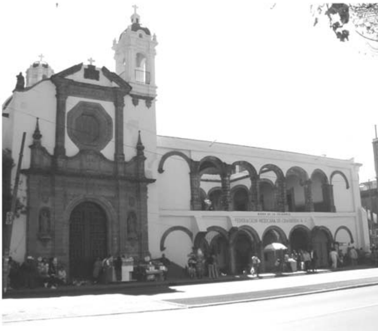
Fotografía 1. Vista actual, fachada norte de la iglesia y parte del claustro de Monserat (Archivo de la Dirección de Salvamento Arqueológico, 2004).
