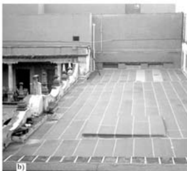
Figura 3. a) Interior de la galería de los Monolitos con los tragaluces en función, hacia 1930. b) Techo de la Sala de Monolitos en 2005, se aprecia la huella de uno de los tragaluces instalados por instrucciones de Luis Caraza.
