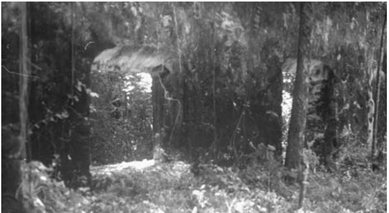
Figura 10. Fachada lateral de la iglesia.
