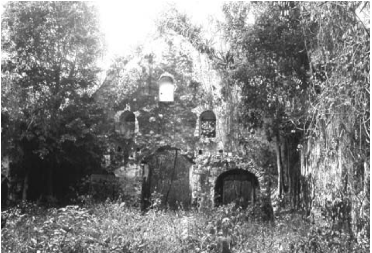
Figura 12. Vista general del coro.
