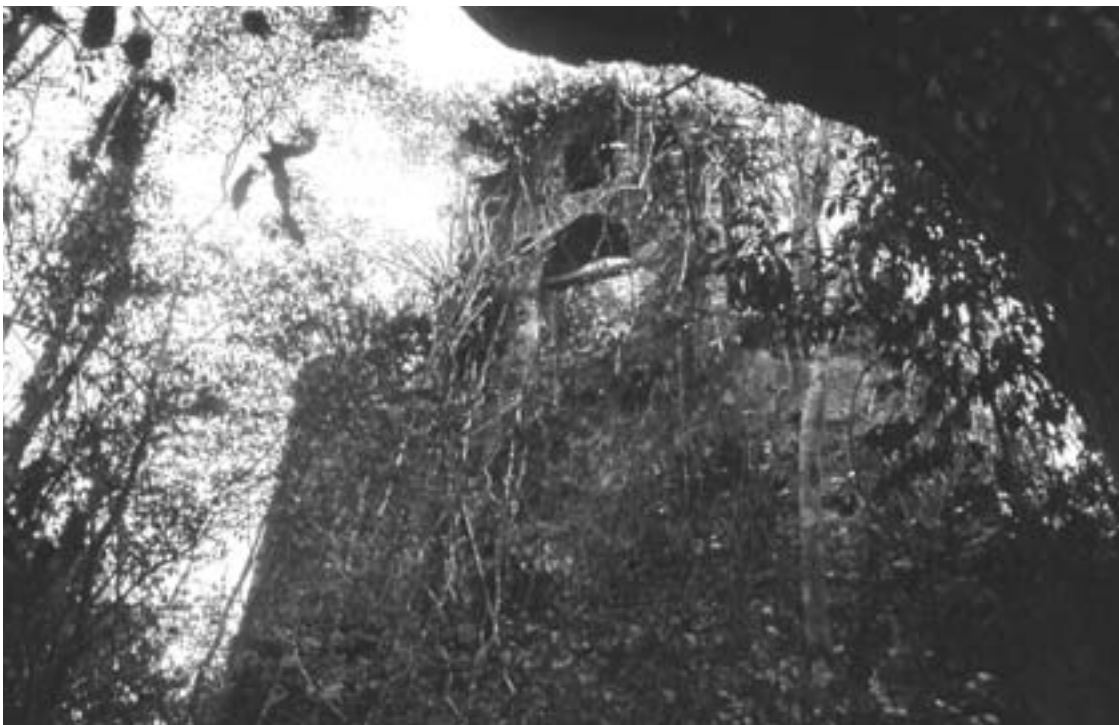
Figura 14. Muro lateral del presbiterio con la espadaña.
