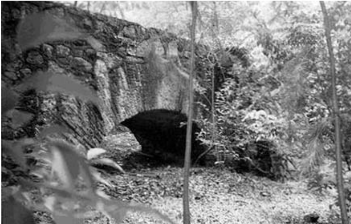
Fotografía 7. Arcada del acueducto de Santa Fe restaurado, frente al elevador, 1999.
