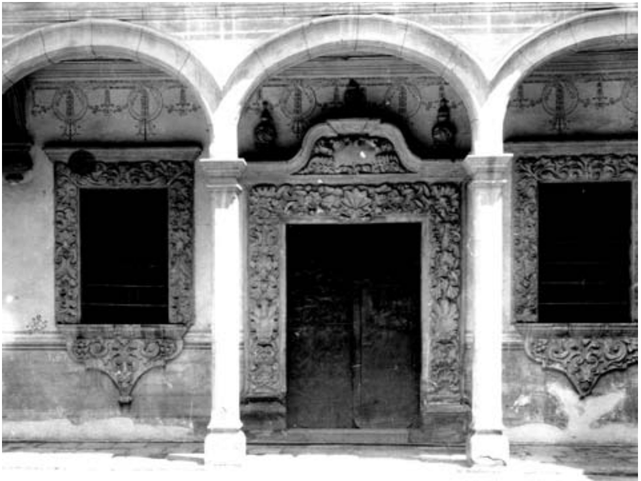
Fotografía 6. Capilla (ca. 1885). Fotografía ca. 1935. La puerta está recubierta de lámina de hierro. Archivo Geográfico de la CNMH, INAH, exp. Real Caja.
