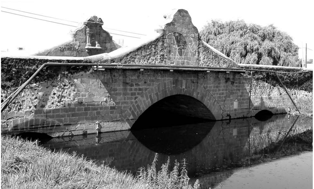
Figura 2. Vista lateral desde el noreste, que muestra los tres arcos. Los laterales casi están cubiertos totalmente por el nivel del agua.
