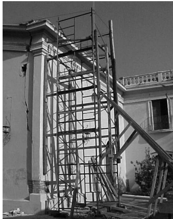
Imagen 13. Apuntalamiento de la fachada lateral para evitar la abertura de grieta vertical. Archivo de la Sección de Monumentos Históricos del Centro INAH Colima, 2004.
