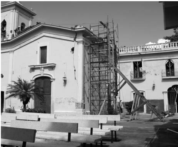
Imagen 12. Apuntalamiento de la capilla de la Estancia. Archivo de la Sección de Monumentos Históricos del Centro INAH Colima, 2004.
