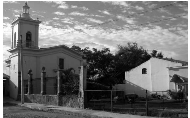
Imágenes 26 y 27. Obra terminada de la capilla de la Estancia. Detalle de barda atrial; vista general exterior y vista del área de anexos. Archivo de la Sección de Monumentos Históricos del Centro INAH Colima, 2004.
