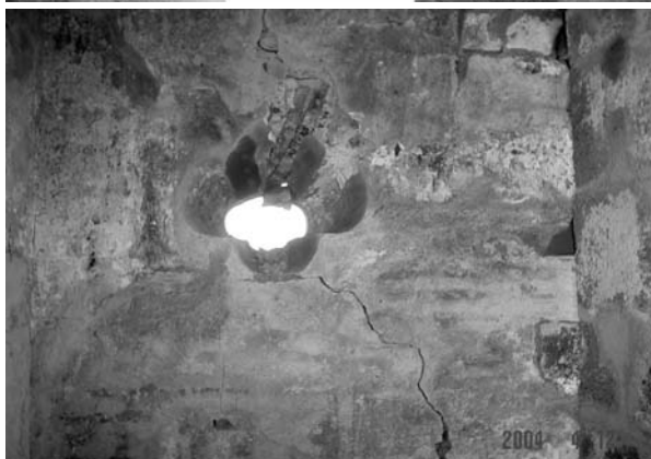
Imágenes 2 y 3. Vistas del interior de la torre campanario de la capilla de Nogueras. Archivo de la Sección de Monumentos Históricos del Centro INAH Colima, 2004.
