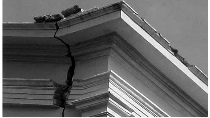
Imágenes 14, 15 y 16. Daños provocados por el sismo de enero de 2003, en muros, arcos, balcones, cornisas en la capilla de la Estancia. Archivo de la Sección de Monumentos Históricos del Centro INAH Colima, 2003. Archivo de la Sección de Monumentos Históricos del Centro INAH Colima, 2004.
