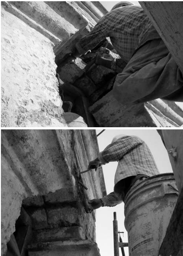
Imágenes 6 y 7. Trabajos realizados en la torre campanario, fachada principal, consistentes en la recolocación de las dóvelas de cantera e inyección para la consolidación del arco. Archivo de la Sección de Monumentos Históricos del Centro INAH Colima, 2004.
