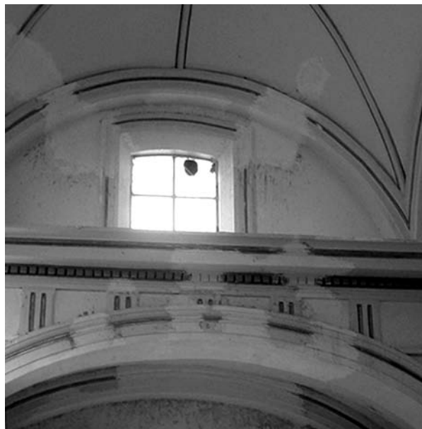
Imagen 29. Interior de la Capilla de Chiapa. Archivo de la Sección de Monumentos Históricos del Centro INAH Colima, 2004.
