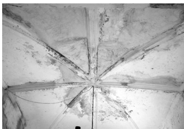
Imágenes 17 y 18. Intervenciones a base de inyecciones en grietas de muros, arcos, balcones y cornisas del área de los anexos. Archivo de la Sección de Monumentos Históricos del Centro INAH Colima, 2004.
