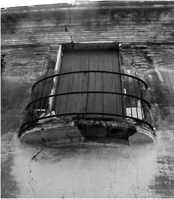
Imágenes 14, 15 y 16. Daños provocados por el sismo de enero de 2003, en muros, arcos, balcones, cornisas en la capilla de la Estancia. Archivo de la Sección de Monumentos Históricos del Centro INAH Colima, 2003. Archivo de la Sección de Monumentos Históricos del Centro INAH Colima, 2004.
