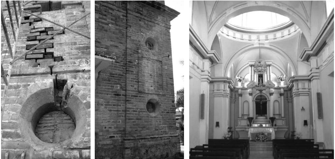
Imágenes 37, 38 y 39. Vistas del proceso de obra. Sustitución de piezas de barro fracturadas, consolidación y pintura en áreas intervenidas al interior del templo. Obra terminada en mayo de 2005. Archivo de la Sección de Monumentos Históricos del Centro INAH Colima, 2005.
