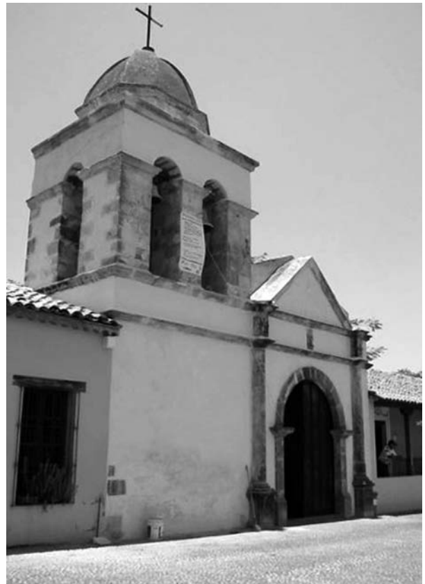
Imagen 10. Obra terminada. Capilla de Nogueras. Archivo de la Sección de Monumentos Históricos del Centro INAH Colima, 2004.
