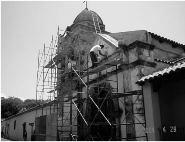
Imagen 5. Capilla de Nogueras durante la intervención. Archivo de la Sección de Monumentos Históricos del Centro INAH Colima, 2004.
