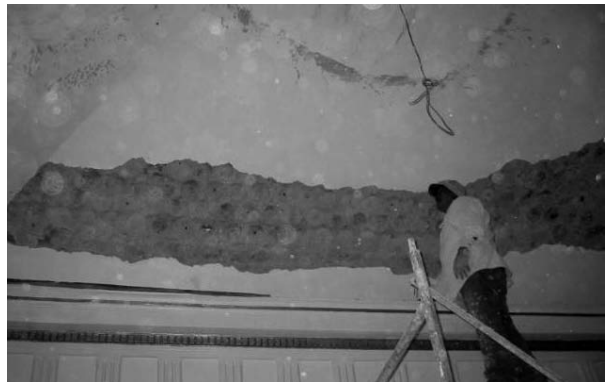
Imágenes 34 y 35. Detalles de muro en nave y vista interior de bóveda aligerada con cántaros de barro, descubierta parcialmente. Archivo de la Sección de Monumentos Históricos del Centro INAH Colima, 2005.
