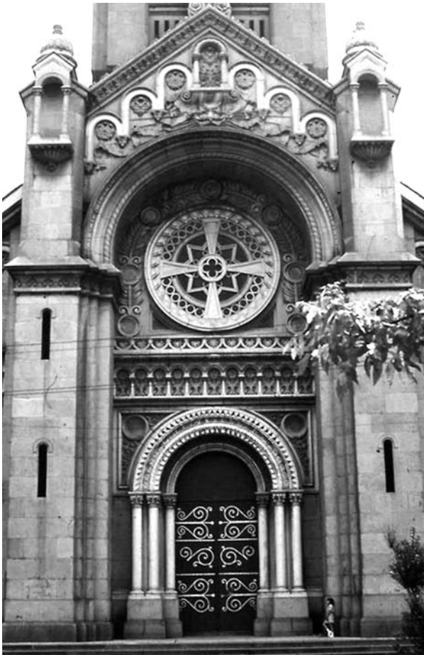
Fotografía 1. Fachada principal del templo de la Sagrada Familia, colonia Roma, ciudad de México. Cortesía del arquitecto Manuel Berúmen Rocha. 3
