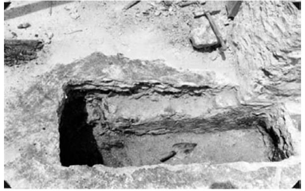
Figura 8. Las calas de exploración revelaron que los arcos de medio punto sostenidos por pilares de sección cuadrangular hechos de mampostería, son las arquerías mencionadas en 1904, que originalmente eran paramentos lisos con varios accesos. Archivo Centro INAH-Campeche.
