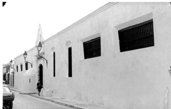
Figura 3. Fachada del edificio de la ex cárcel de Campeche en la que se observa la disposición de las ventanas y el garitón de la guardia. Archivo Centro INAH-Campeche.
