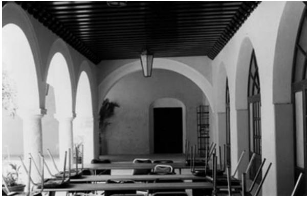
Figura 11. Reconstrucción de la arquería colapsada con base en la evidencia arquitectónica e histórica. Archivo Centro INAH-Campeche.
