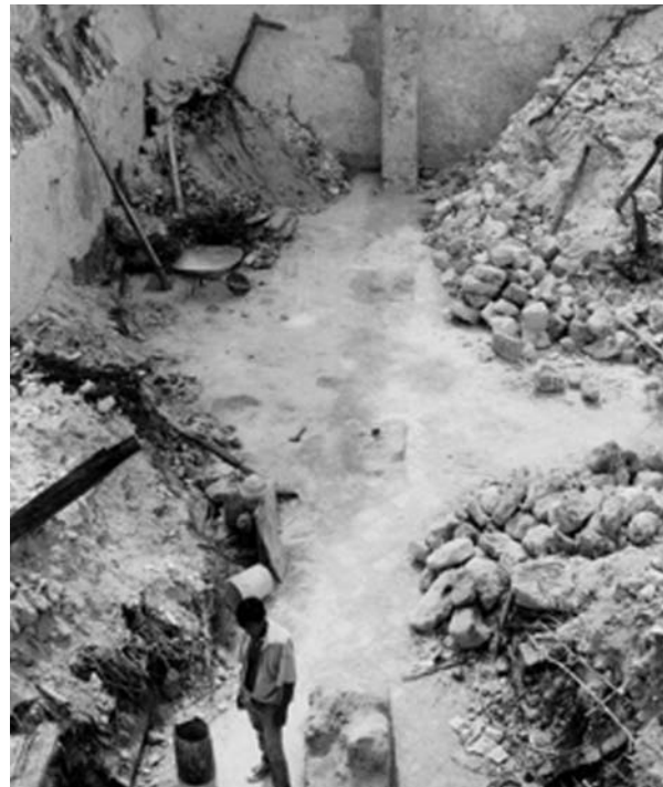
Figura 10. Evidencias del arranque de los pilares de sección cuadrangular que sostuvieron una arquería ya colapsada. Archivo Centro INAH+Campeche.
