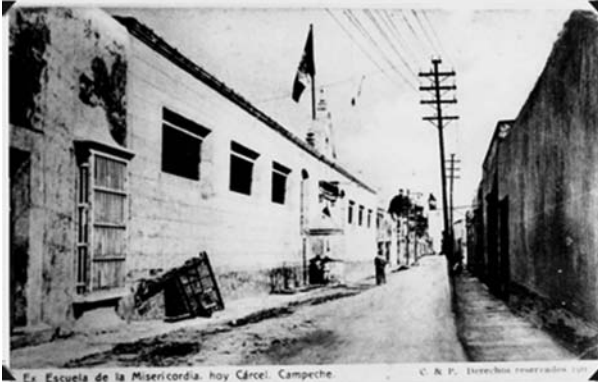
Figura 6. Aspecto que presentaba la fachada de la cárcel pública de Campeche a principios del siglo XX. Obsérvese la disposición de las ventanas, el garitón y el almohadillado. Archivo Centro INAH-Campeche.
