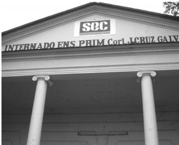
Figura 10. Frontón de la fachada del edificio principal de la Escuela Coronel J. Cruz Gálvez, mayo 2005. Fotografía proporcionada por la arquitecta Juana Gómez Badillo.
