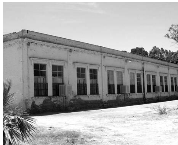
Figura 11. Fachada del edificio principal de la Escuela Coronel J. Cruz Gálvez, mayo 2005. Fotografía proporcionada por la arquitecta Juana Gómez Badillo.
