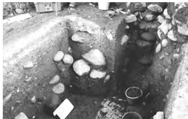
Figura 9. Trabajos arqueológicos al pie del campanario de la fachada del ex convento dominico de Tecpatán, con cimentación realizada mediante grandes piedras de canto rodado del río cercano, en 2003. Foto: Elsa Hernández Pons.
