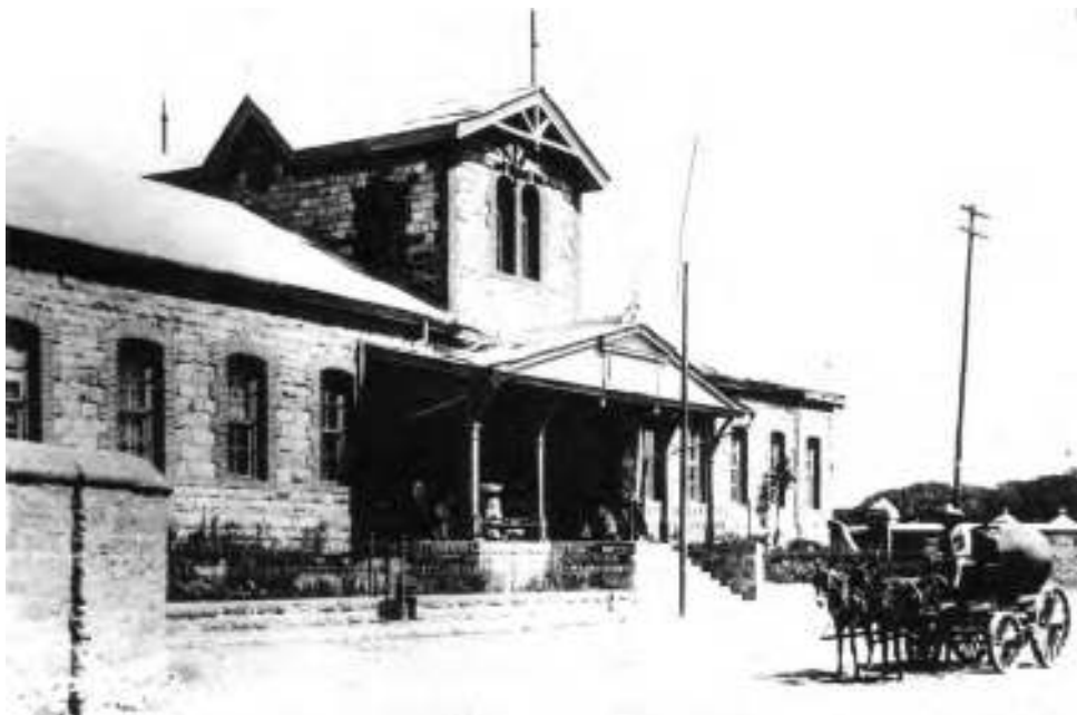
Figura 11. Casa de estación Puebla del Ferrocarril Mexicano del Sur, s. f. Fuente: Museo Nacional de los Ferrocarriles Mexicanos, Centro de Documentación e Investigación..., op cit.
