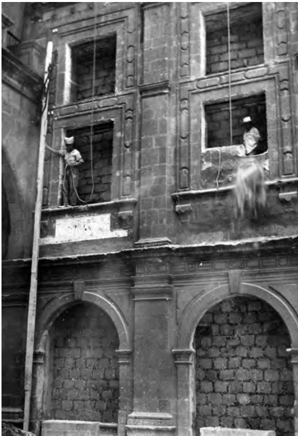
Fotógrafo no identificado. Los trabajos de restauración emprendidos durante la década de 1950 pusieron al descubierto los materiales y los sistemas constructivos utilizados para cegar los vanos de la fachada sur, ca. 1950. Fototeca de la CNMH-INAH.
