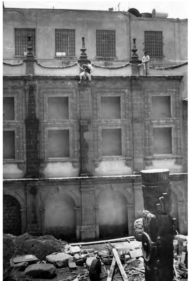
Fotógrafo no identificado. Obras de restauración de la fachada sur del Museo Nacional, ca. 1950. Fototeca de la CNMHINAH.
