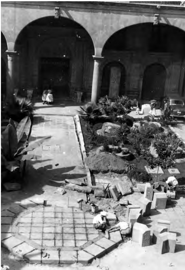
Fotógrafo no identificado. Proceso de construcción de la fuente del patio central, ca. 1950. Fototeca de la CNMH-INAH.
