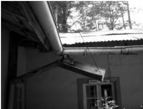
Figura 8. Captación de agua de lluvia en la mina Dos Estrellas, siglo XIX. Tlalpujahua, Michoacán. Fotografía de Yolanda D. Terán Trillo, 2008.
