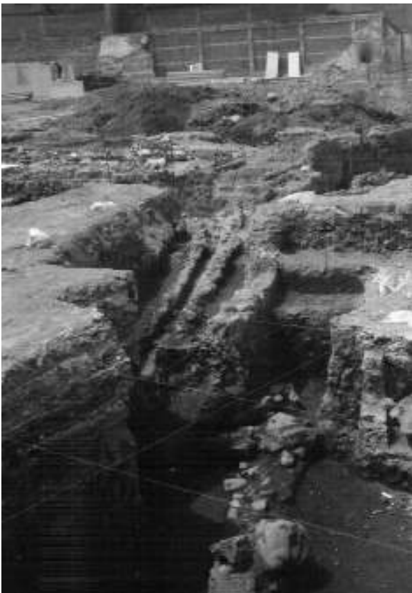
Figura 3. Unidad 41-57, caño de agua roto por intrusiones modernas. Fotografía de José Antonio Urdapilleta Pérez durante los trabajos del Proyecto Arqueológico SRE-Tlatelolco Edificio Nuevo, México, SSA-INAH, 1992.
