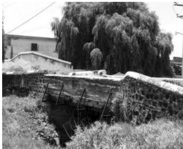
Figura 10. Puente de la hacienda de Atenco, Estado de México, desde el noroeste. Fotografía de Guillermo Boils Morales, julio de 2008.
