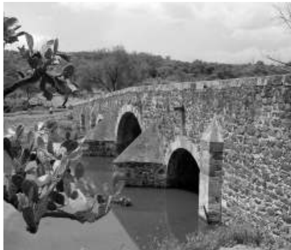
Figura 4. Tajamares pronunciados a ambos lados del arco central del puente de Calderón. Fotografía de Guillermo Boils Morales, agosto de 2006.
