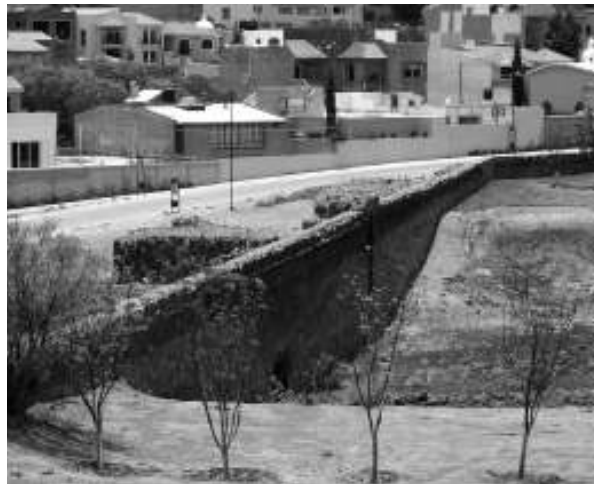
Figura 1. Vista norte-sur de la presa de Bernárdez.
