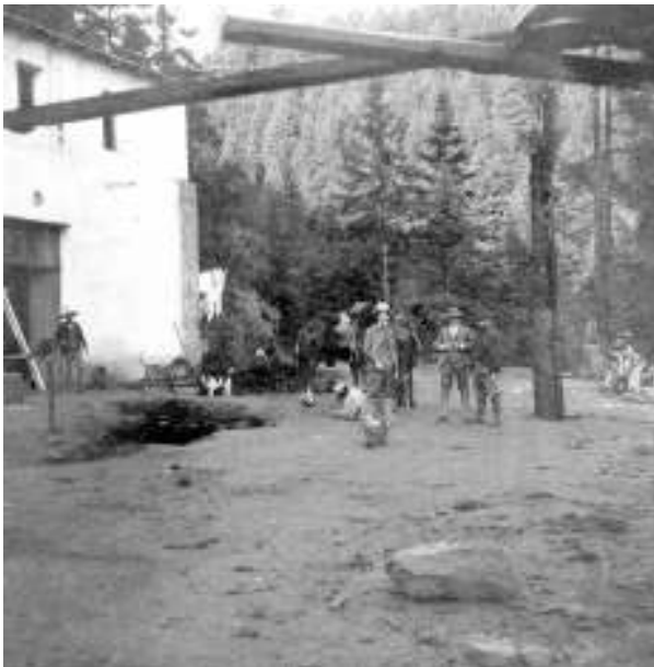
Figura 4. Vista de una parte del edificio de mampostería con dos pisos y techos de viguetas de acero que se encontraba cerca del salto de Xalancocotla. AHA, Aprovechamientos Superficiales, caja 4288, exp. 57263, f. 162.
