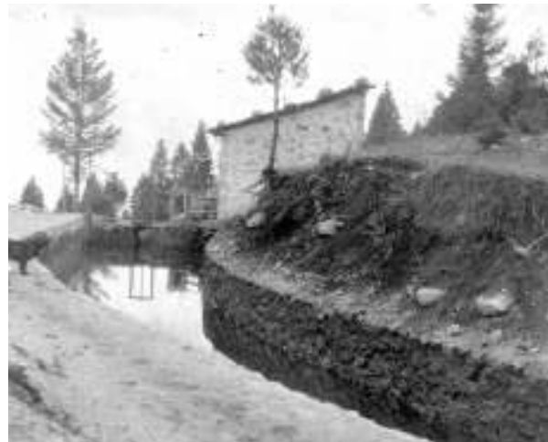
Figura 5. Canal que abastecía las turbinas de la fábrica La Hormiga. AHA, Aprovechamientos Superficiales, caja 4288, exp. 57263, f. 162.
