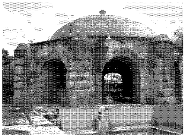
Figura 29. Noria de tiro cubierta del convento; al frente el aljibe. Mama, Yucatán. Fotografía de José Manuel Chávez Gómez.
