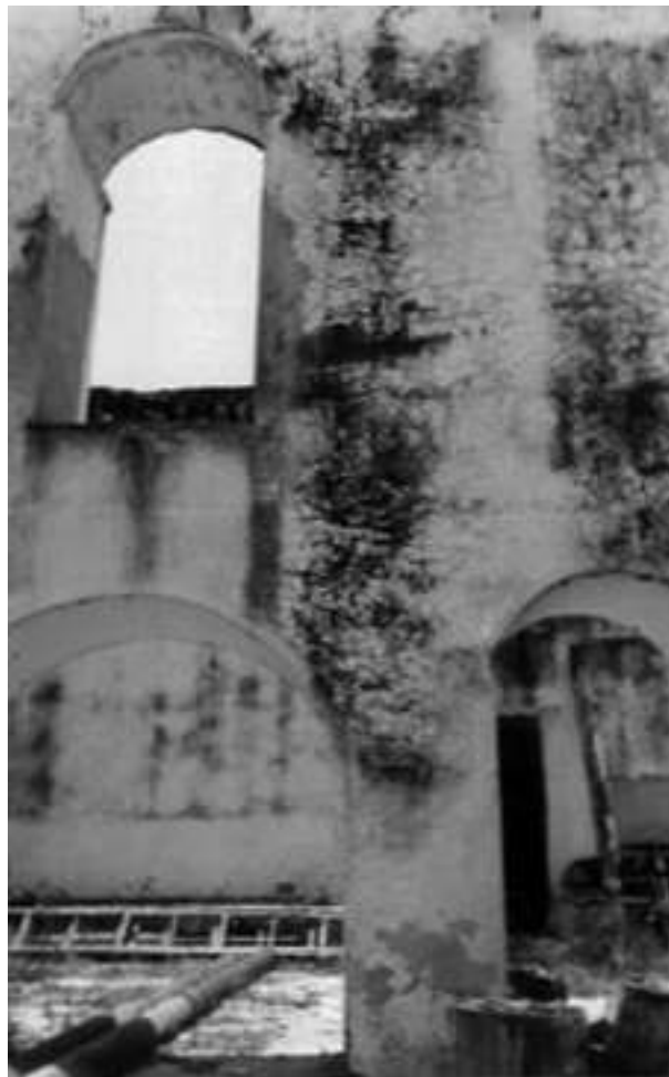
Figura 5. a) Patio central y fachada del molino “San Miguel”. Arquitectura tipo hacienda (ca. 1890). b) Detalle arquitectónico del área de la troje. Molino “San Miguel”. Fotografías de Humberto Morales.
