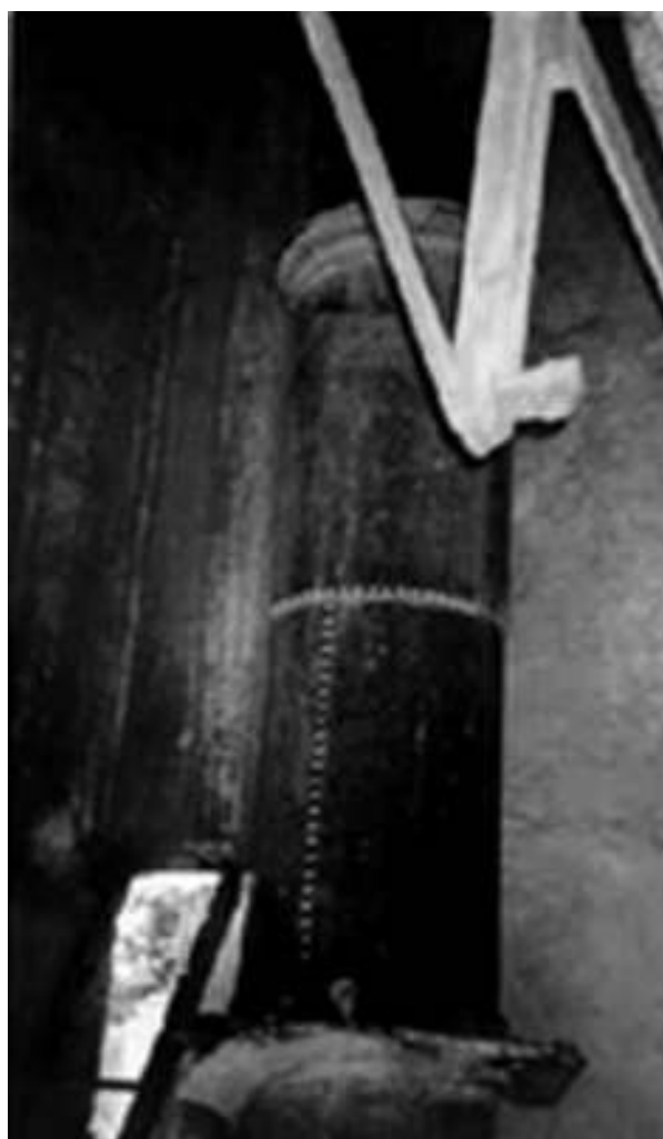
Figura 17. Caldera de vapor vertical en la fábrica "Talamantes", Chihuahua (ca. 1857). Fotografía de Alma Rosa Cobos. En Alma Rosa Cobos et al. , "Propuesta de arqueología industrial en el sur del estado de Chihuahua", en Sergio Niccolai y Humberto Morales (coords.), La cultura industrial mexicana , México, CMCPI/BUAP, 2003, se registra esta caldera vertical como "turbina", lo cual es inexacto; este tipo de calderas verticales las vemos por primera vez en Tepic, en la fábrica "Bellavista", y datan de los años 1837-1843, presumiblemente de fabricación belga o francesa.
