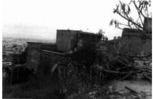
Figura 2. Detalle de los restos de adobe y ladrillo de la estructura original del antiguo molino. Fotografía de Humberto Morales.
