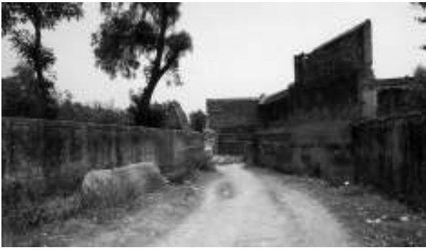
Figura 8. Acceso posterior del molino "San Miguel". Surco original de las aguas desviadas para la fuerza motriz. Acatzingo, Puebla. Fotografía de Humberto Morales.
