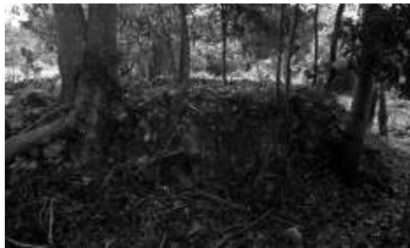
Figura 8. Estado actual de uno de los baluartes del Fuerte de Yo'okop. Fotografía de L. A. Martos, 1997.
