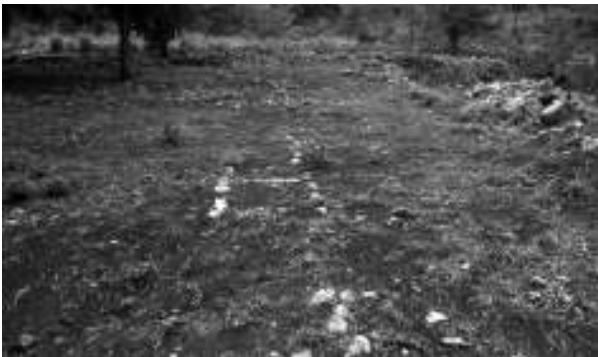
Figura 16. Detalle de uno de los andadores. Al fondo se aprecia uno de los baluartes. Fotografía de L. A. Martos, 1997.
