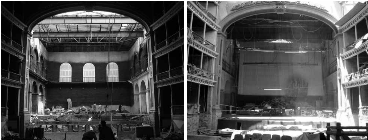
Figura 17. Proceso de intervención en mecánica teatral y cubierta de escenario y trasforo. Sección Monumentos Históricos, INAH Colima, 2007.
