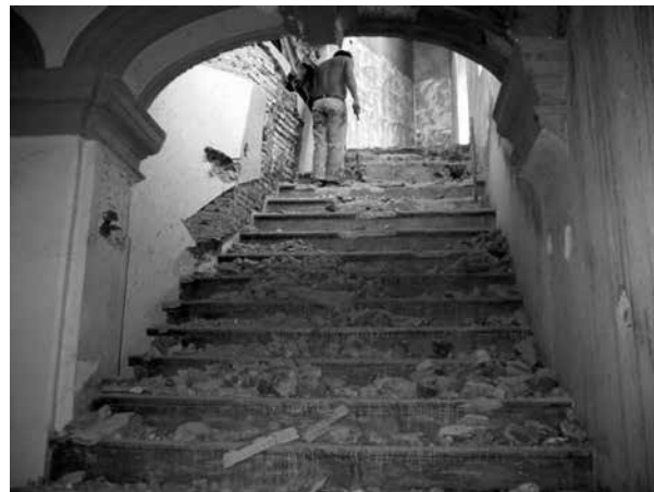
Figura 10. Proceso de intervención en escalera lateral derecha. Sección Monumentos Históricos, INAH Colima, 2006.
