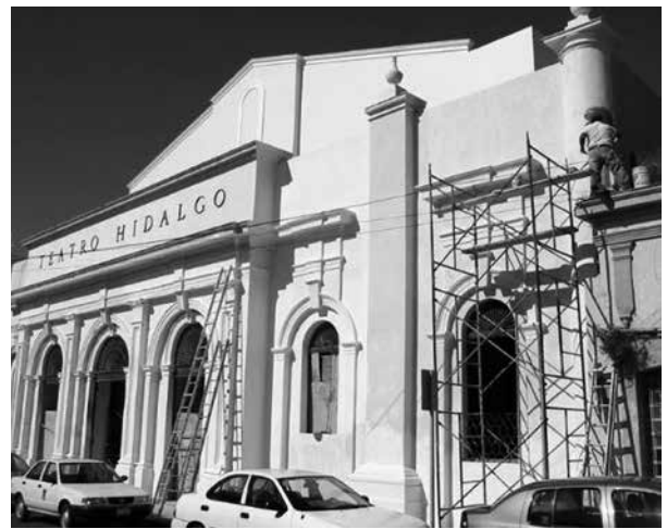
Figura 12. Proceso de intervención del edificio. Sección Monumentos, INAH Colima, 2006-2007.
