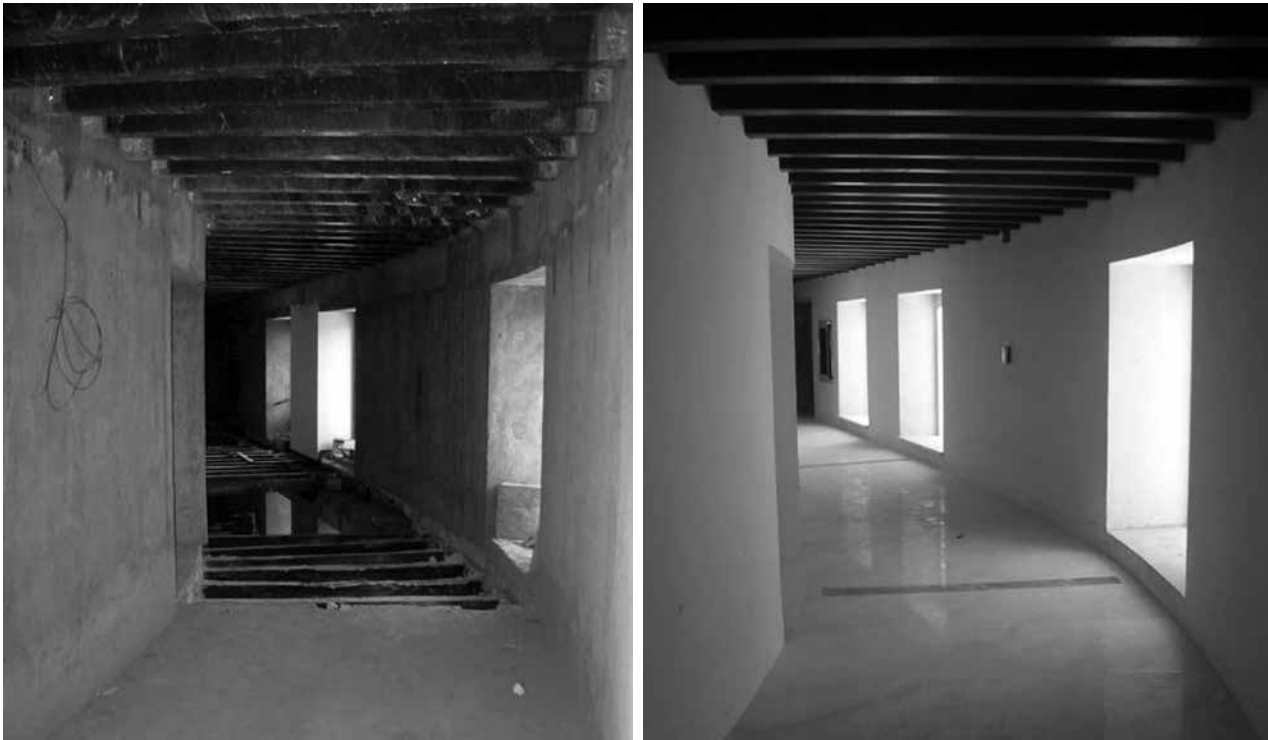
Figura 13. Proceso de intervención en área de pasillos. Sección de Monumentos Históricos, INAH Colima, 2006-2007.
