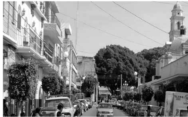
Figura 13. Tehuacán. Calle de Toledano, hoy Calle 2a. de la 1a. sur. 2005.
