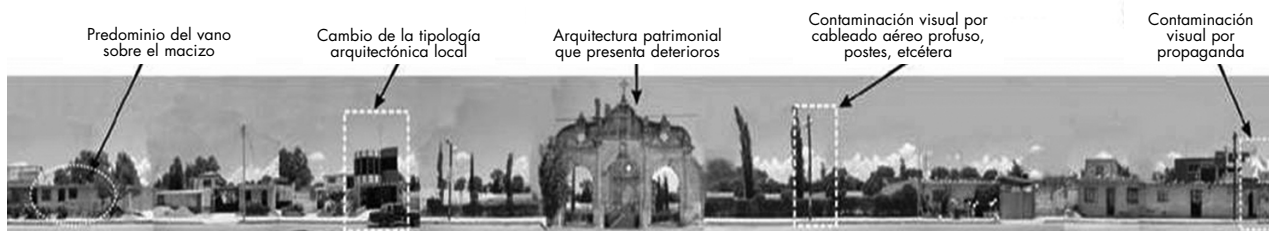
Figura 11. Fachada norte de la plaza de Quecholac. Este lado de la plaza es el más alterado. Existe aún arquitectura patrimonial que presenta deterioros graves debido en gran parte por la total indiferencia de autoridades para su conservación. Se observa la invasión de nuevas tipologías por la inserción de construcciones de dos niveles de baja calidad y desde luego ninguna intención de integración con el contexto. En las construcciones de dos niveles predomina el vano sobre el macizo, donde los vanos de ventanas y puertas no tienen una adecuada proporción. La contaminación visual por cableado aéreo profuso, postes, señalización y propaganda son algunos de los elementos que más se visualizan.
