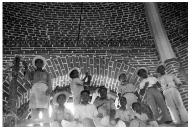
Figura 5. Foto que muestra el fin de los trabajos de la fuente de Chiapa de Corzo; el pie de foto del álbum dice “Detalle interior de la fuente, después de la reconstrucción, 1944”. Fototeca Constantino Reyes Valerio, CNMH-Conaculta-INAH, México, 126 s/n.
