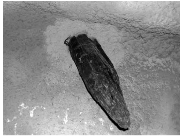
Figura 2. Estacados. La estacada es un procedimiento constructivo que no está hecho para comunicar algún mensaje, sino para permanecer oculta a la percepción de los visitantes. Sin embargo, es posible observarla a través de las ventanas arqueológicas del Sagrario de la Catedral o en la zona arqueológica del Templo Mayor.
