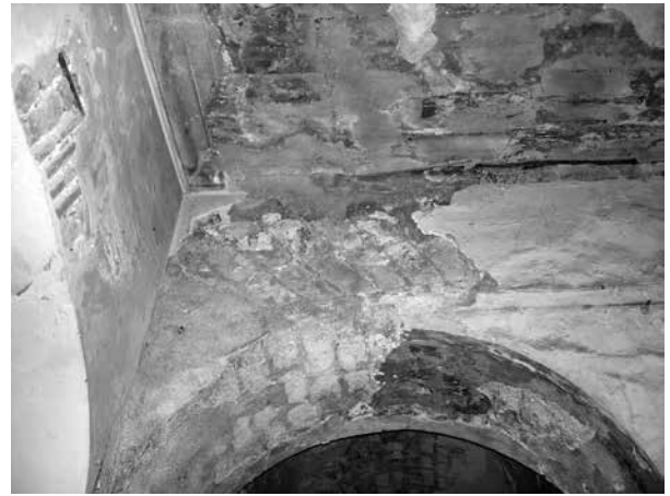
Figura 8. Arco de medio punto que se localiza en la escalera principal del convento de Jesús María. Foto de Leopoldo Rodríguez, 2010.
