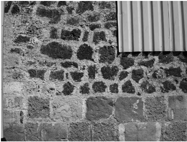
Figura 9. Muro exterior oriente del convento de Jesús María. Sobre sillares de piedra dura (rodapié) está el tezontle, que ocupa la mayor parte del muro para aligerarlo. Foto de Leopoldo Rodríguez, 2010.
