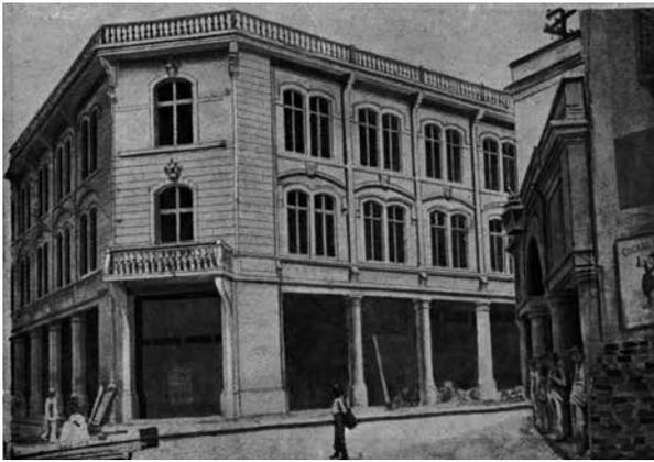
Figura 20. Magasins del Candado, à Mérida (Mexique). Construction entièrement en béton armé avec terrasse. Le béton armé Relevé des travaux exécutés année 1903, p. 67.
