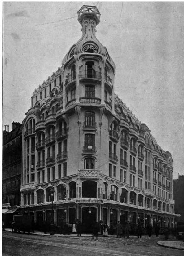
Figura 24. La Maison Félix Potin. Entièrement en béton armé, sauf le parement des façades de 4 étages qui sont en pierre de taille. Surface couverte 1.250 m. "La Maison Félix Potin", en *Le béton armé*, núm. 88, septième de 1905, lámina I.
