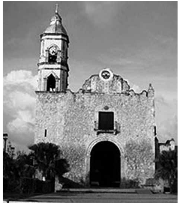
Figura 1. Fachada principal de la parroquia de San Román, ubicada en la calle 10 esquina con calle Bravo en el Barrio de San Román, San Francisco de Campeche, Campeche.
