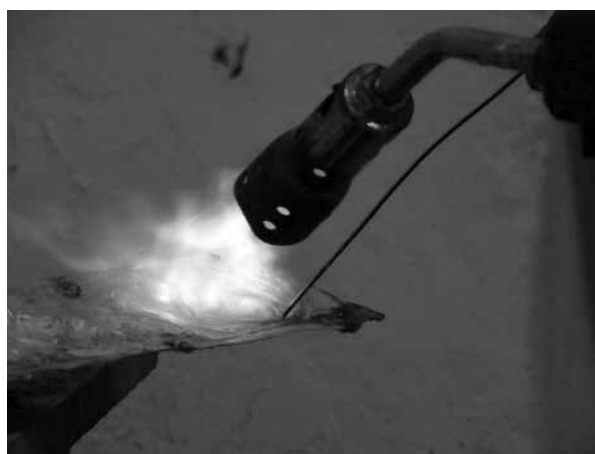
Figura 34. Aplicación de soldadura.
