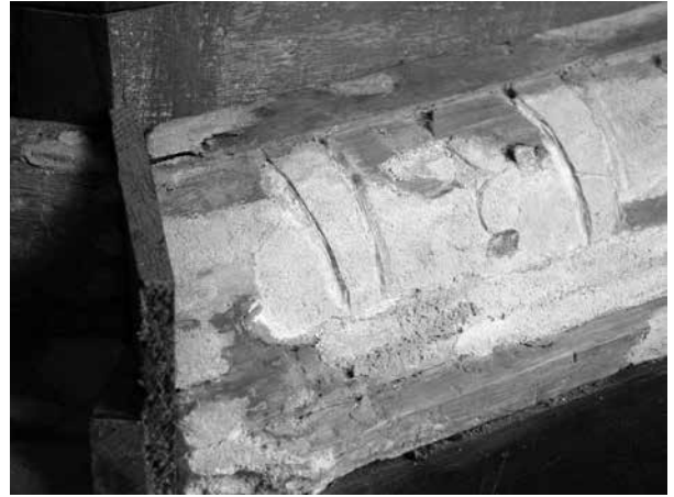
Figura 27. Detalle de zona de resane.
