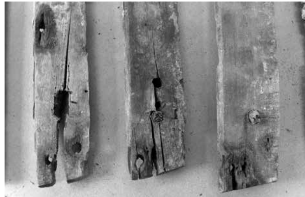
Figura 14. Estado de conservación de las molduras que decoran la peana, previamente a su restauración. En la imagen se observan algunos taquetes de madera con que fue construida originalmente la peana.
