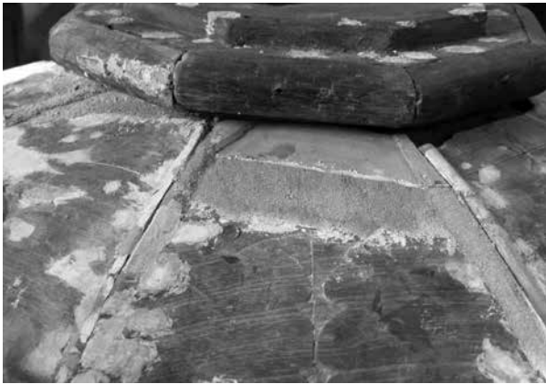
Figura 22. En faltantes de mayor tamaño fue necesario injertar pedazos de madera que pudiera resistir los esfuerzos mecánicos de soportar la cruz del Cristo.
