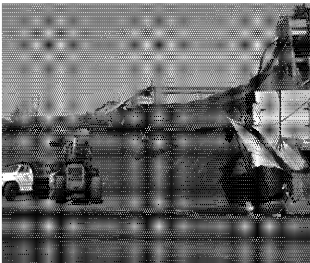
Figura 6. Carga de los camiones de volteo.
