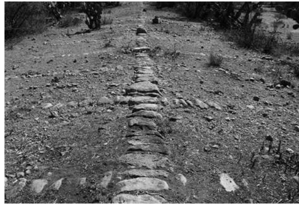
Figura 4. Empedrado del Camino Real. Pueden apreciarse los niveles y el bombeo formando una traza.
