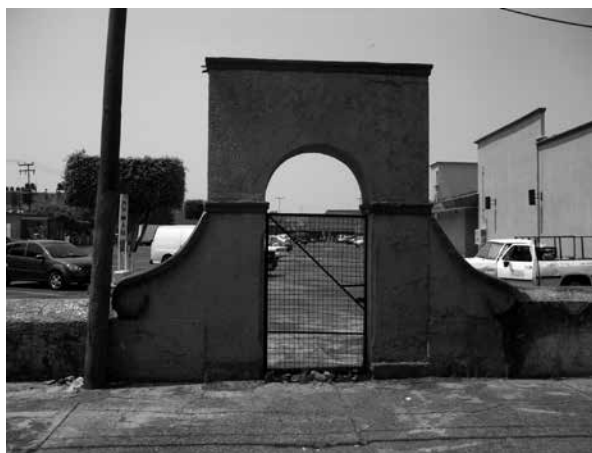
Figura 10. Sección de la barda que delimita el estacionamiento del establecimiento comercial, callejón Cuitláhuac. Fotografía de Gustavo Becerril, 2011.
