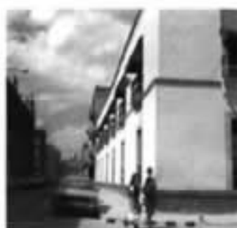
Vivienda renovada en la calle de Echeveste, ciudad de México (después del sismo del 1909-1985). Fotografía de Paulina Lavista.
