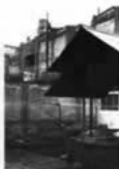
Vivienda afectada en la calle de Echeveste, ciudad de México (sismo 1909-1985). Fotografía de la Fototeca de la Coordinación Nacional de Monumentos Históricos, INAH.
