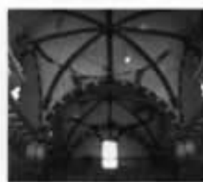
Templo de San Pedro Apóstol, Coquimán, Colima (sismo 21-01-2003).
