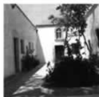
Vivienda renovada en la calle de Colombia núm. 60, ciudad de México (después del sismo del 1909-1985). Fotografía de Paulina Lavista.
