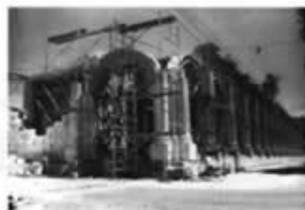
Palacio Municipal de Villa Tejuapam de la Unión, Oaxaca (sismo 30-09-1999).
