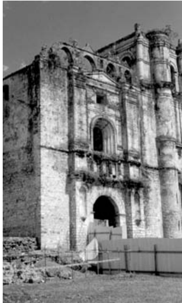
Fachada del templo de Santo Domingo. Fotografía de la autora, 2002.
