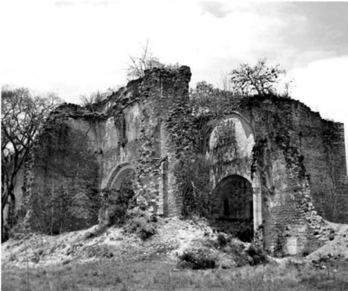
Interior del templo de Copanaguastla. Foto: Constantino Reyes Valerio, marzo de 1961.
