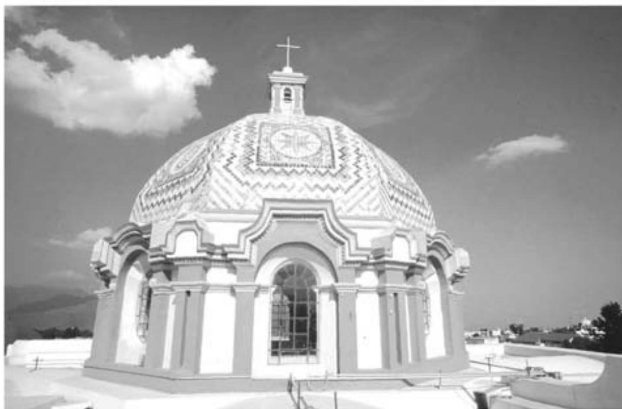
Figura 13. Cúpula sobre el crucero del templo, con gajos recubiertos de azulejos de colores.
