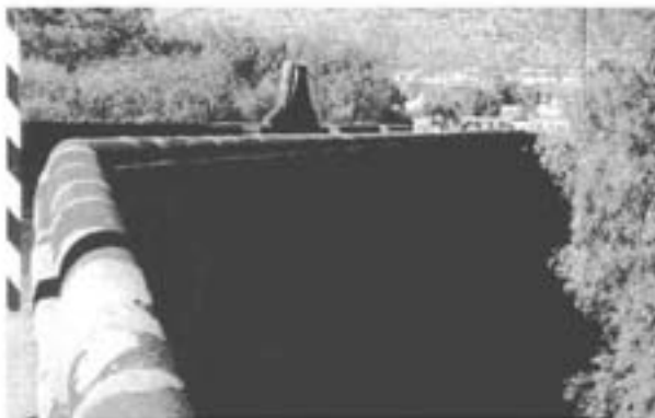
Figura 8. Muro barandal desde el lado nordeste. Foto: G. Boila, 2004.
