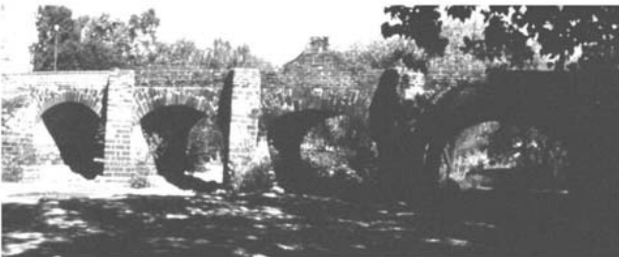
Figura 11. Vista de conjunto del puente. Foto: G. Boils, 2004.
