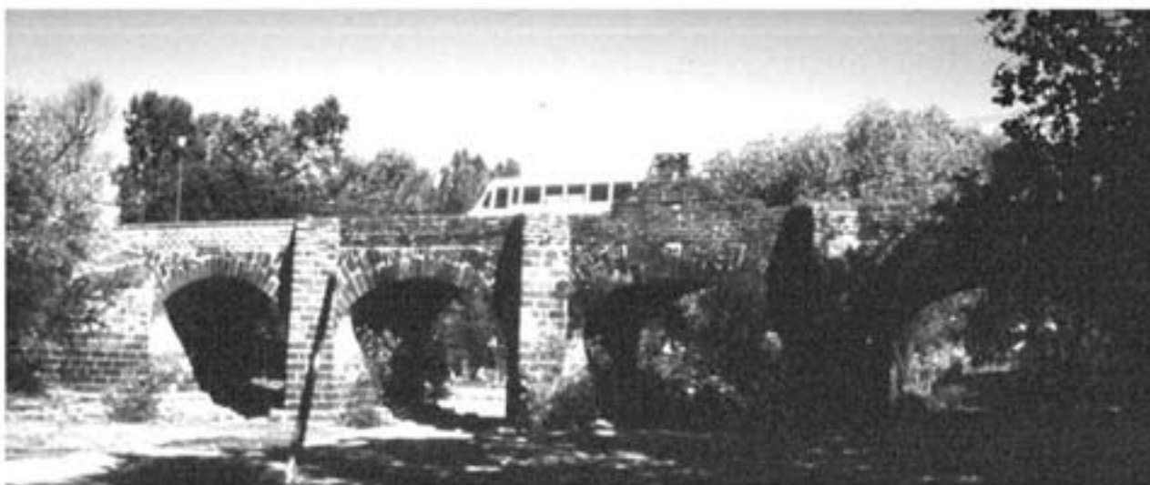
Figura 10. Autobús pasando sobre el puente. Foto: G. Boils, 2004.
