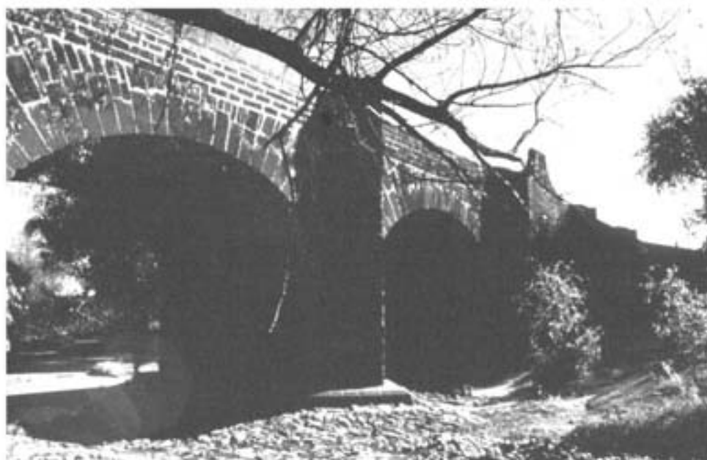
Figura 14. Parte baja del puente desde el suroeste. Foto: G. Boils, 2004.
