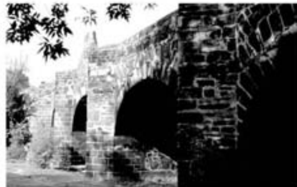
Figura 9. Vista del puente desde el sureste. Foto: G. Boila, 2004.
