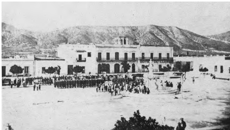
Figura 5. La Fuente de los Delfines en la plaza de Zaragoza, 1865.
