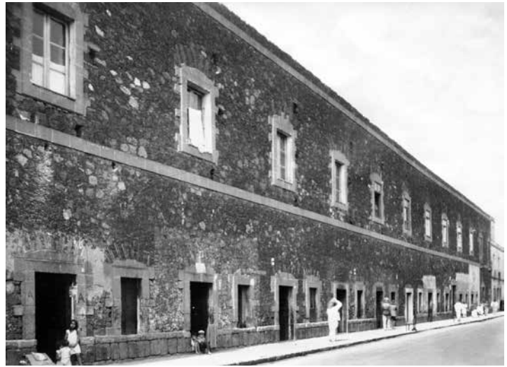
Figura 38. En esta fotografía del primer tercio del siglo XX se observa la fachada de los inmuebles de Margil 7, 9 y 13-15. Archivo Fotográfico de la Coordinación Nacional de Monumentos Históricos, INAH.
