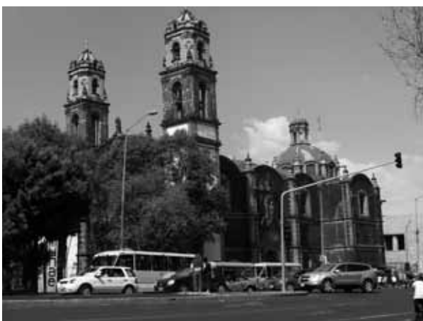
Figura 6. Imagen actual de la construcción y su impacto urbano; a diferencia de muchas de las que se alzaron en el trazado del centro de la ciudad, ésta se expone a la perspectiva que brinda la Alameda, por lo que su agraciada forma es más fácil de aprehensión; se muestra en su integridad sin necesidad de imaginar las partes.
