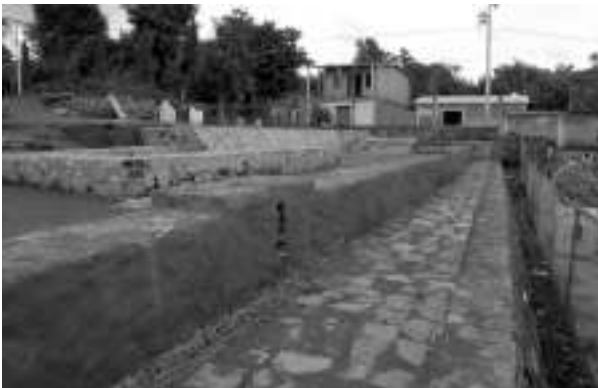
Figura 12. Muro de contención y delimitación de la terraza sur del convento y del área de la huerta. En segundo plano se aprecia el canaleta intramuro, con una de las salidas que drenaban hacia la huerta.
