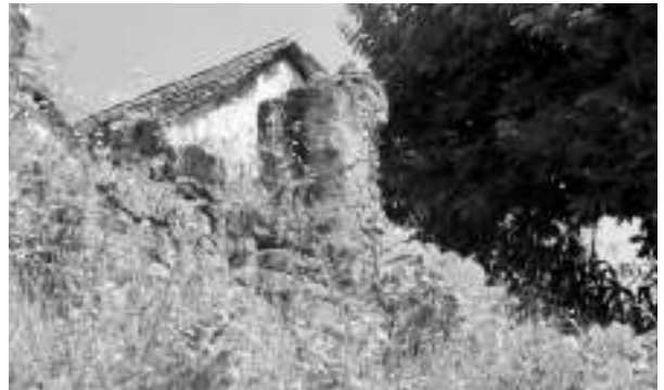
Figura 6. Vestigios de una probable compuerta y del muro de contención de la plataforma del convento.
