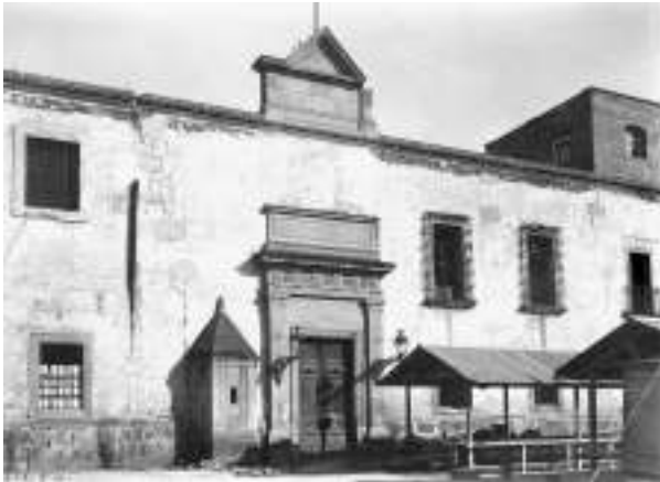
Figura 4. Fachada del Recogimiento de Santa María Magdalena. FCRV-CNMH. 0059-084-001.
